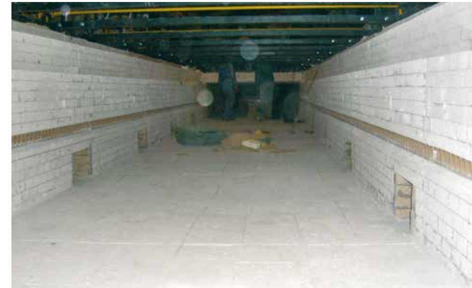
Vista interna della zona di cottura del forno sopracitato durante la fase di rifacimento di tutti i materiali refrattari. Internal view of the firing zone of the above mentioned kiln during regeneration, involving also refractory materials. Vista interna zona de cocción de dicho horno durante la reconstrucción de todos los materiales refractarios. Vue interne zone de cuisson du four sur mentionné durant la phase de réfection des matériaux réfractaires.
