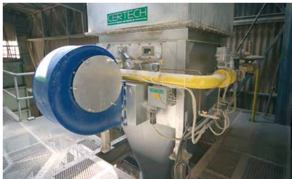
Dettaglio bruciatore in vena d'aria. Detail of the duct burner. Detalle quemador en vena de aire. Détail brûleur en veine d'air.
