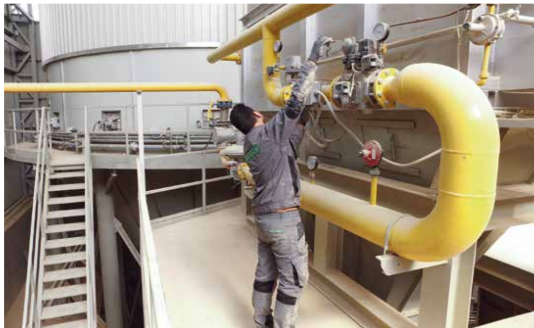
Dettaglio rampa gas bruciatore. Detail of burner gas ramp. Detalle rampa gas quemador. Détail rampe gaz brûleur.
