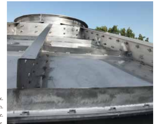
Dettaglio struttura autoportante di cappello e cilindro. Detail of self-supporting structure of cap and cylinder. Detalle estructura autoportante de sombrero y cilindro. Détail structure autoportante de chapeau et cylindre.
