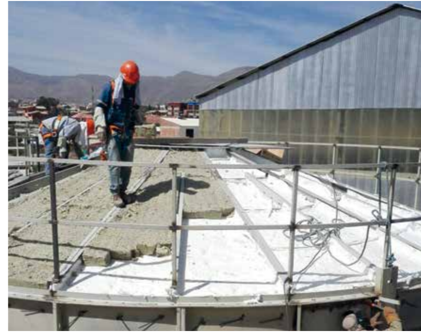
Dettaglio coibentazione cappello CSD 10.000. Primo strato in fibra ceramica e secondo strato in fibra minerale. Detail of the CSD 10.000 cap insulation. First layer in ceramic fibre and second layer in mineral fibre. Detalle aislamiento sombrero CSD 10.000. Primera capa en fibra cerámica y segunda capa en fibra mineral. Détail isolation chapeau CSD 10.000. Première couche en fibre céramique et seconde couche en fibre minérale.
