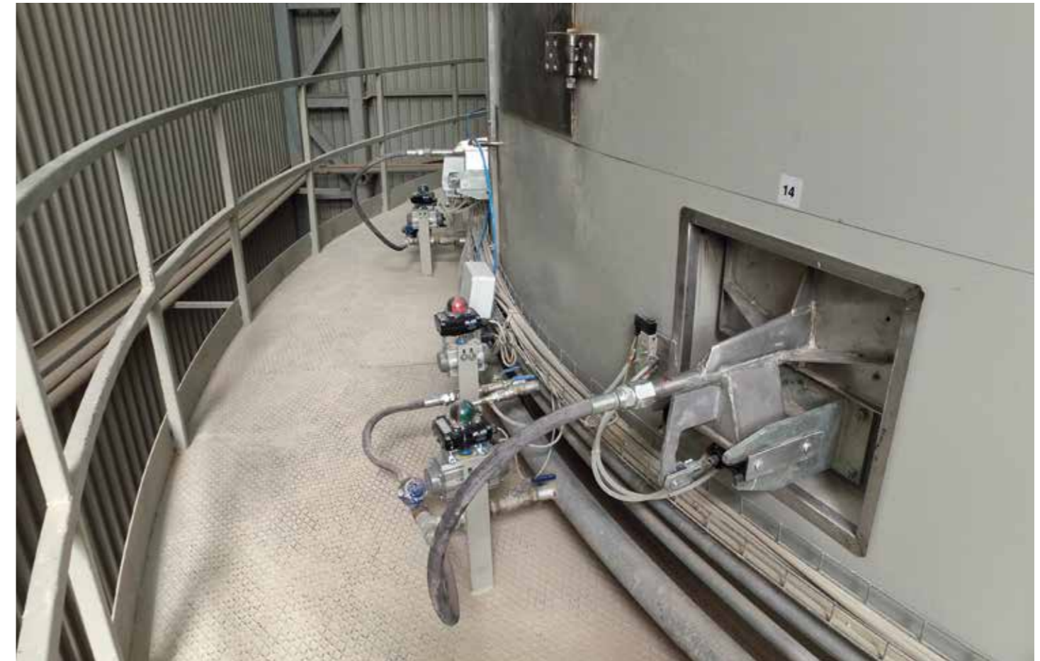
Lancia di spruzzatura dotata di sistema automatico per il lavaggio e lo scuotimento. Spraying lance equipped with automatic system for washing and shaking. Lanza de pulverización equipada con un sistema automático para lavado y sacudida. Lance de pulvérisation équipée d'un système automatique pour le lavage et le secouage.
