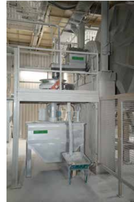
Scarico primo modulo con setaccio sghiaiatore e vasca di trasferimento barbotina. Unloading of the 1st module by means of a sediment excluding sieve and slip transfer tank. Descarga del 1er módulo por medio de un tamiz desarenador y tanque de transferencia barbotina. Déchargement du 1er module à travers d'un tamis dégraveur et cuve de transfert barbotine.
