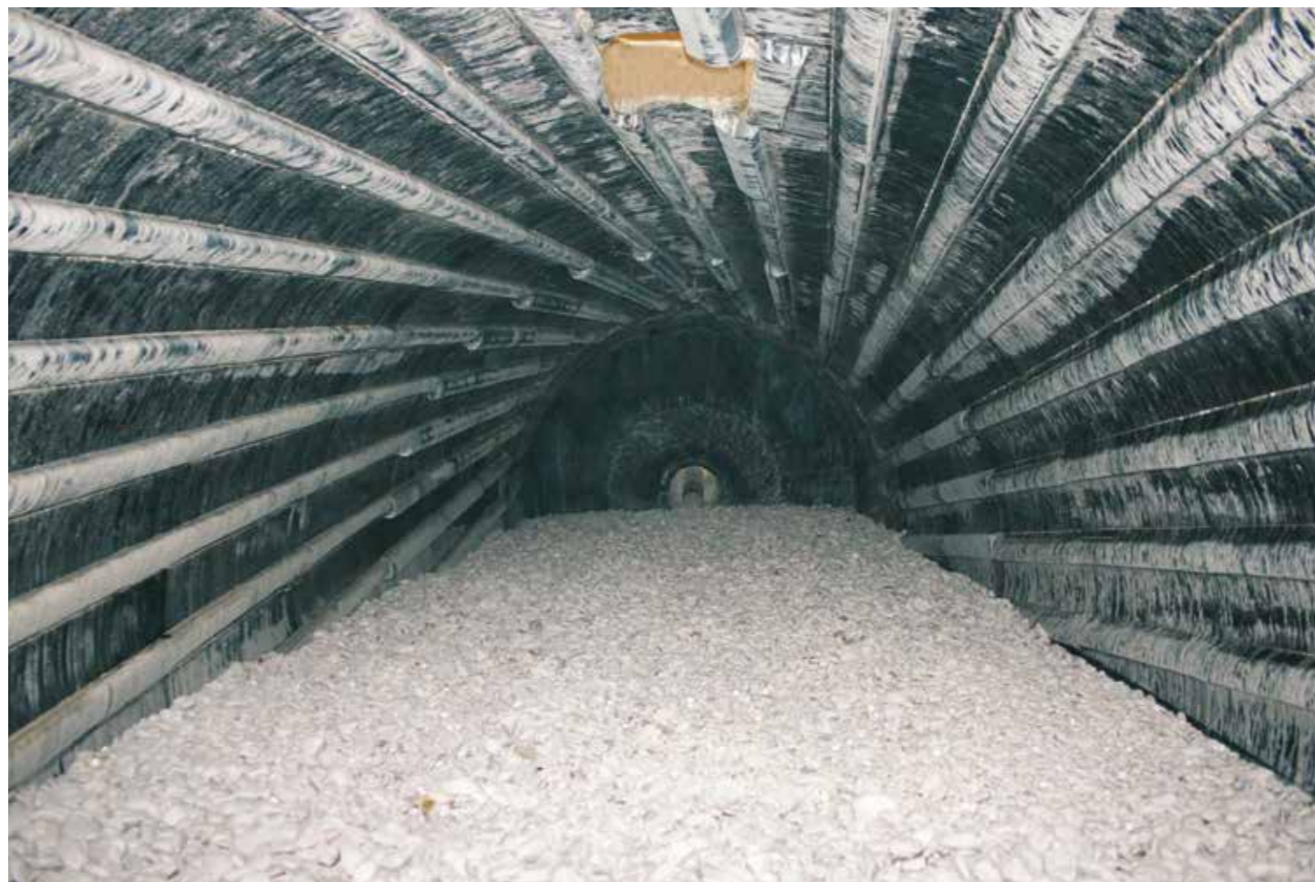
Vista interna della prima camera di un mulino continuo classificante con capacità di 160.000 litri. Internal view of the first chamber of a continuous sorting mill with a capacity of 160,000 litres. Vista interna de la primera cámara de un molino continuo clasificante con capacidad de 160.000 litros. Vue interne de la première chambre d'un moulin continu de classification doté d'une capacité de 160 000 litres.
