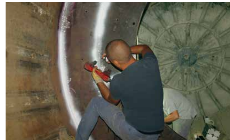
Controllo strutturale della parte interna del mulino con liquidi penetranti ed ultrasuoni. Structural testing of the inner part of the mill with liquid and ultrasound. Control estructural de la parte interna del molino con líquidos penetrantes y ultrasonidos. Contrôle de la structure de la partie interne du broyeur avec des liquides d'imprégnation et des ultrasons
