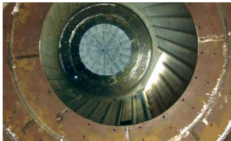
Assemblaggio di n. 2 anelli in acciaio all'interno del mulino. Assembly of the 2 steel ring inside the mill. Ensamblaje de nr. 2 anillos en acero en el interior del molino. Assemblage de nr. 2 anneaux en acier à l'intérieur du broyeur.
