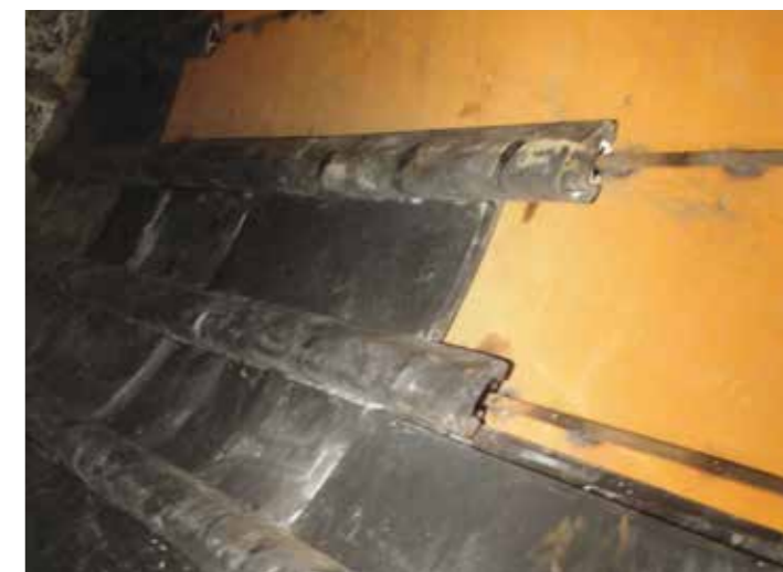
Montaggio parziale del rivestimento in gomma. Partial installation of rubber lining. Montaje parcial del revestimiento de goma. Montage partiel du revêtement en caoutchouc.
