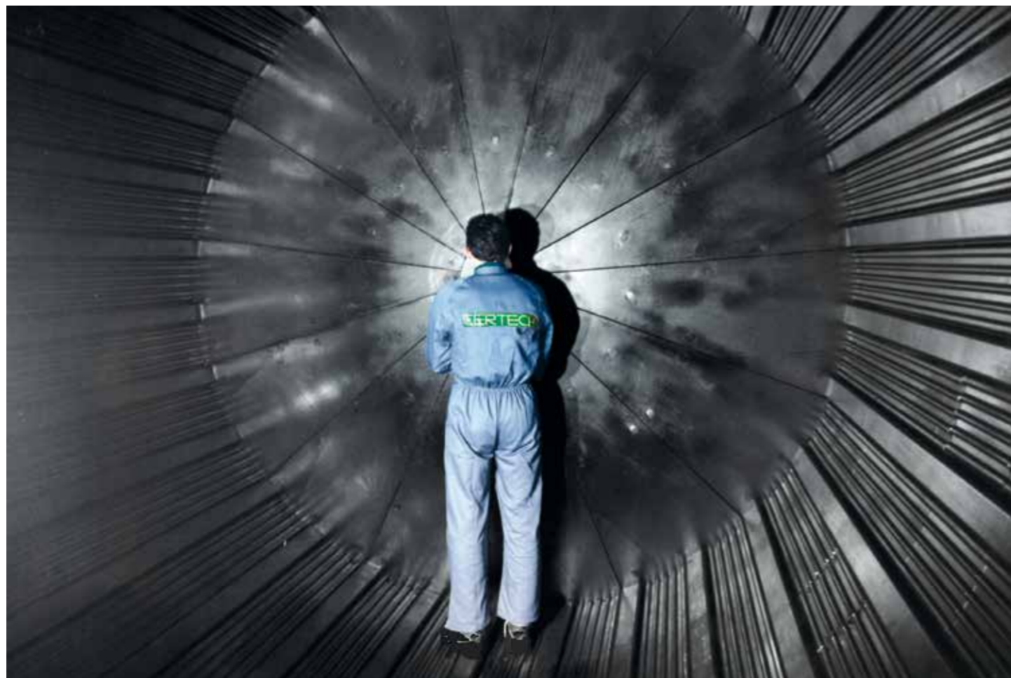
Vista interna di un mulino con rivestimento tipo ROTEX. Internal view of a mill with ROTEX lining. Vista interna de un molino con revestimiento tipo ROTEX. Vue interne d'un moulin avec revêtement type ROTEX.
